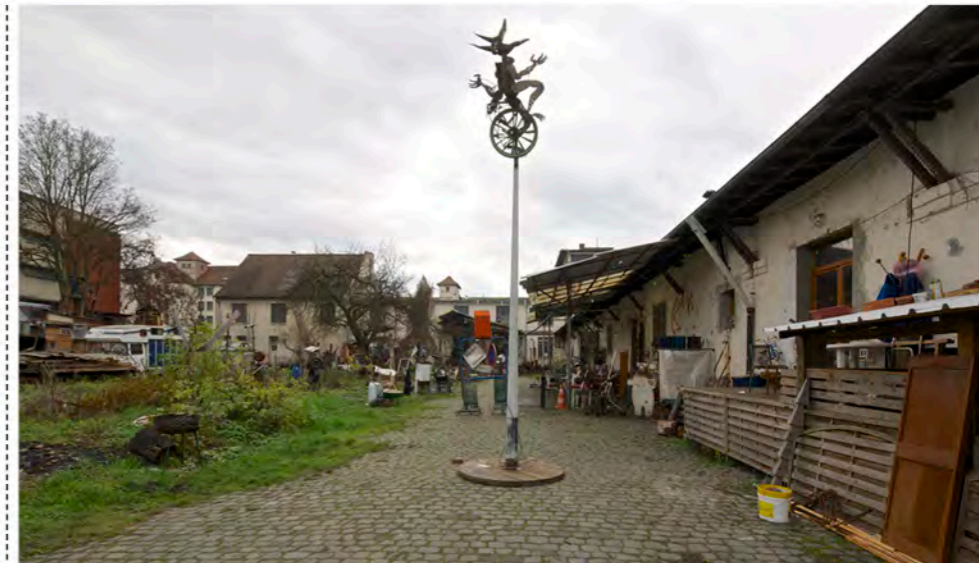
4. La Basse Cour des Miracles depuis l'accès de la rue du Port du Rhin (bâtiment de droite démolì)
