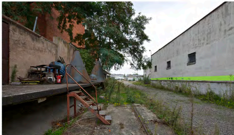
2. Le passage des rails entre la Cavina et l'aile basse de la Sérigraphie
