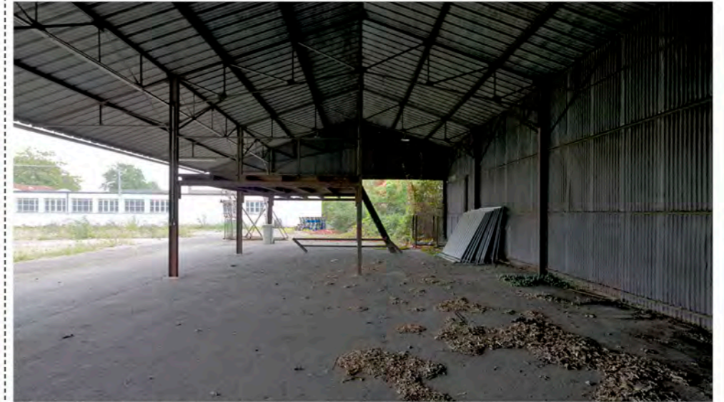
4. Préau - Vue intérieure vers les ateliers
