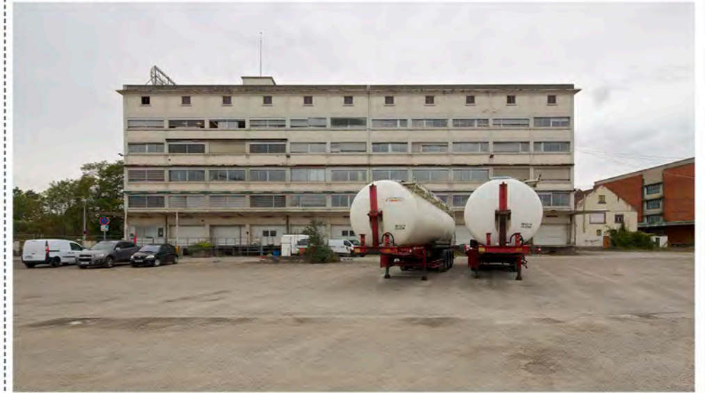
4. Vue sur l'Administration - Avant
