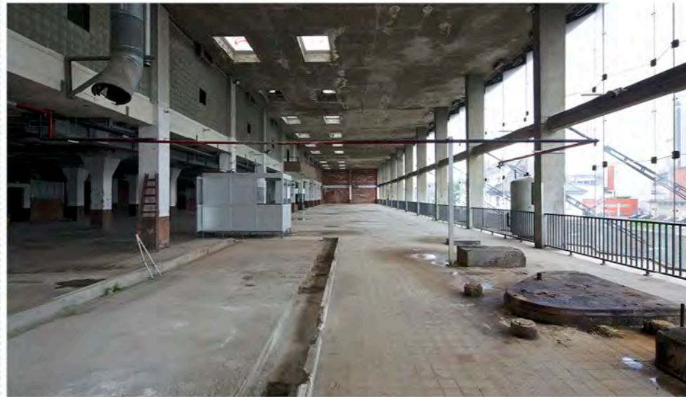
2. Vue sur la salle d'embouteillage au premier étage de la Cave à vin - Avant
