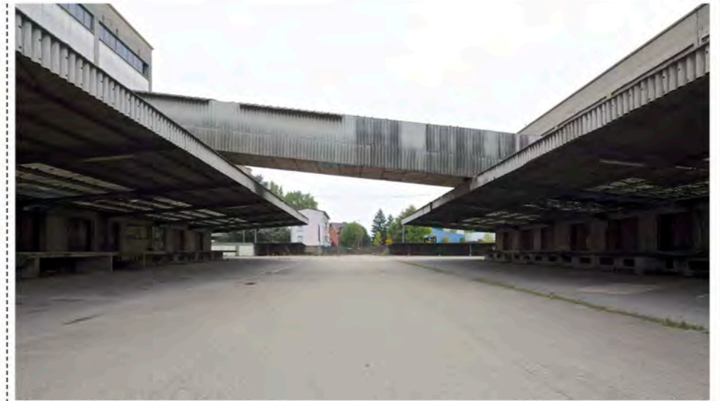
3. Le passage des auvents (passerelle démolie)
