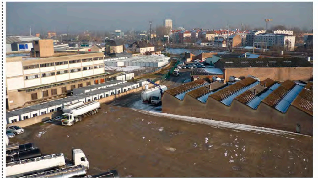
4. Vue sur la cour de l'entreprise Chalot
