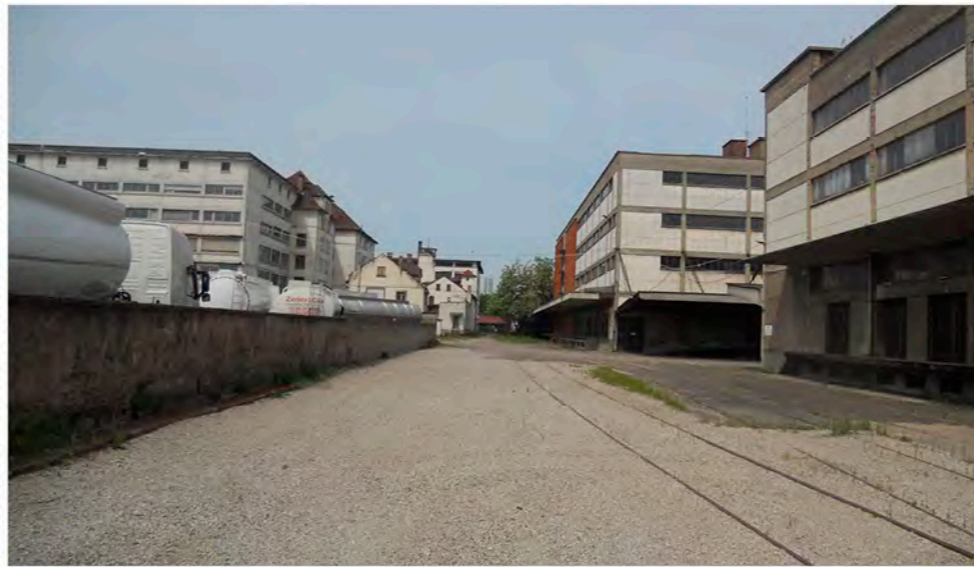
1. Vue sur le passage des rails
