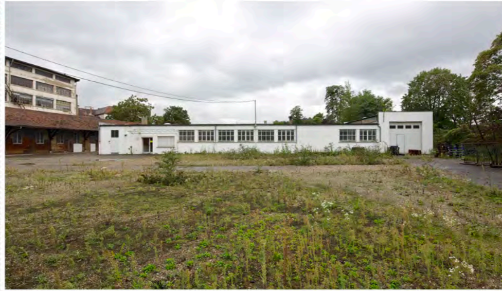
1 - Vue sur les Ateliers de la Menuiserie
