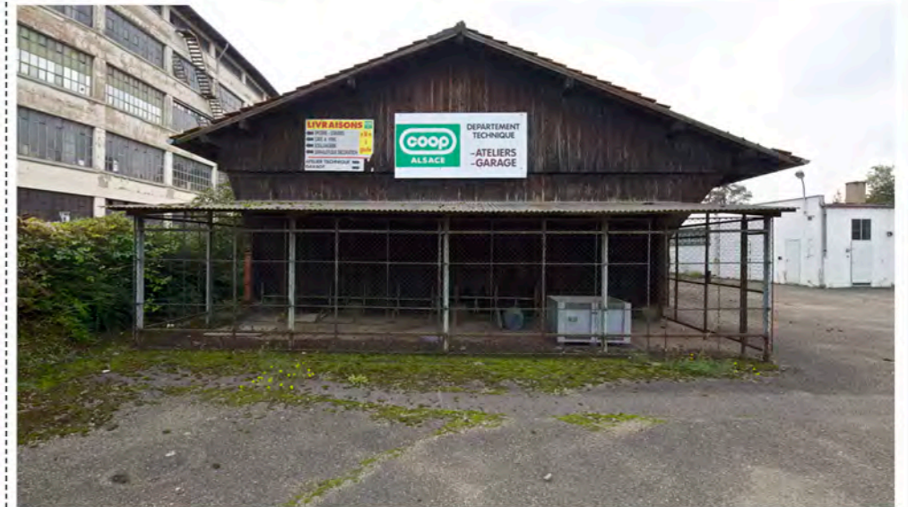
3 - Façade nord des Ateliers bois
