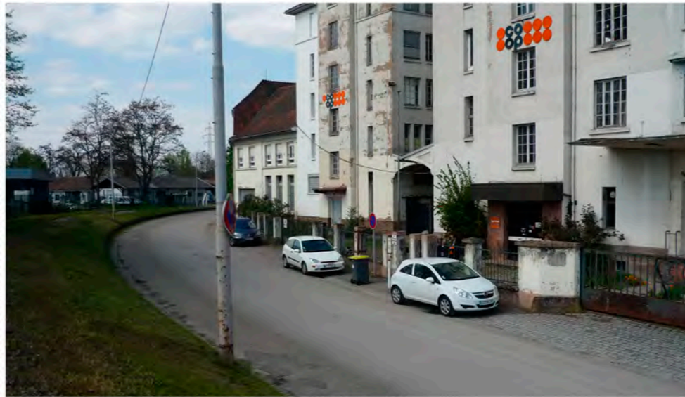
2. Rue de la Coopérative depuis les voies ferrées, l'Administration
