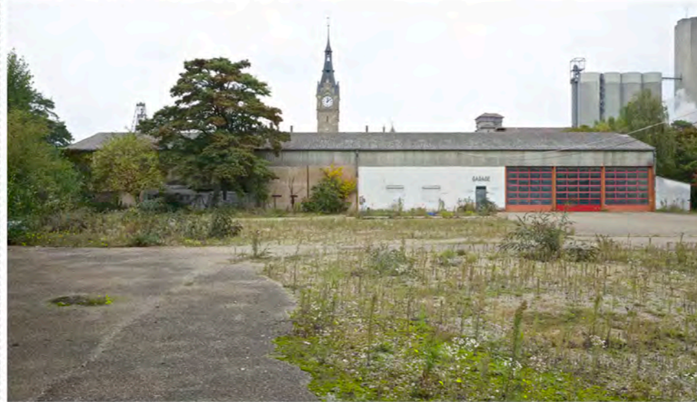
2. Garage - Façade sud - Avant
