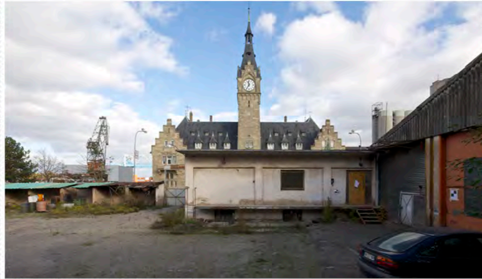
1. Garage - Façade sud des alvéoles du Garage
