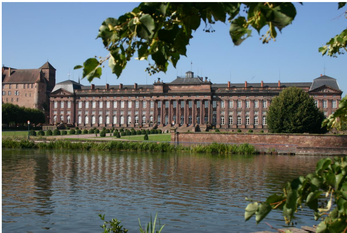
Façade Est du château des Rohan, côté parc et canal, XVIIIe siècle.
